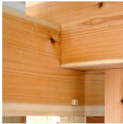
金物を使わない工法、仕口とコミ栓による造作。
